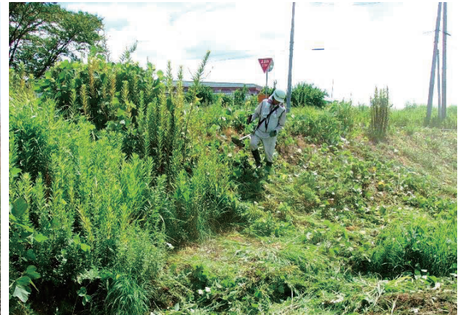
刈払機による除草作業
