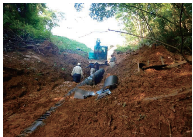
工事管理業務（公共育成牧場復旧工事）
